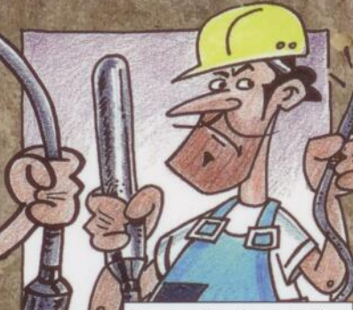
Kies een trilnaald met een dikte en een frequentie die past bij het werk.
