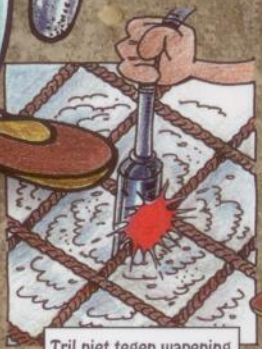
Tril niet tegen wapening of bekistingwerk.
